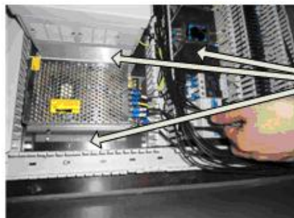
图表 5 安装挡板用电木板，接地通过一个细长的导线，无法保证可靠接
