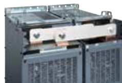
取下盖板的状态 (不包含母线)
